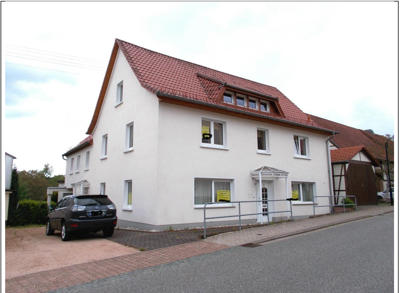
Straßenansicht Haus 57, links, leicht verdeckt vom PKW, der Eingang zu Haus 55
