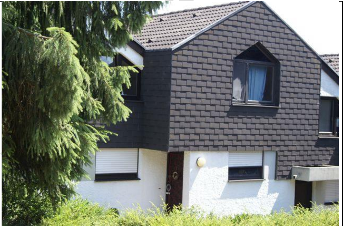
Das Fenster des oberen großen Zimmers, darunter das Küchenfenster der Wohnung
