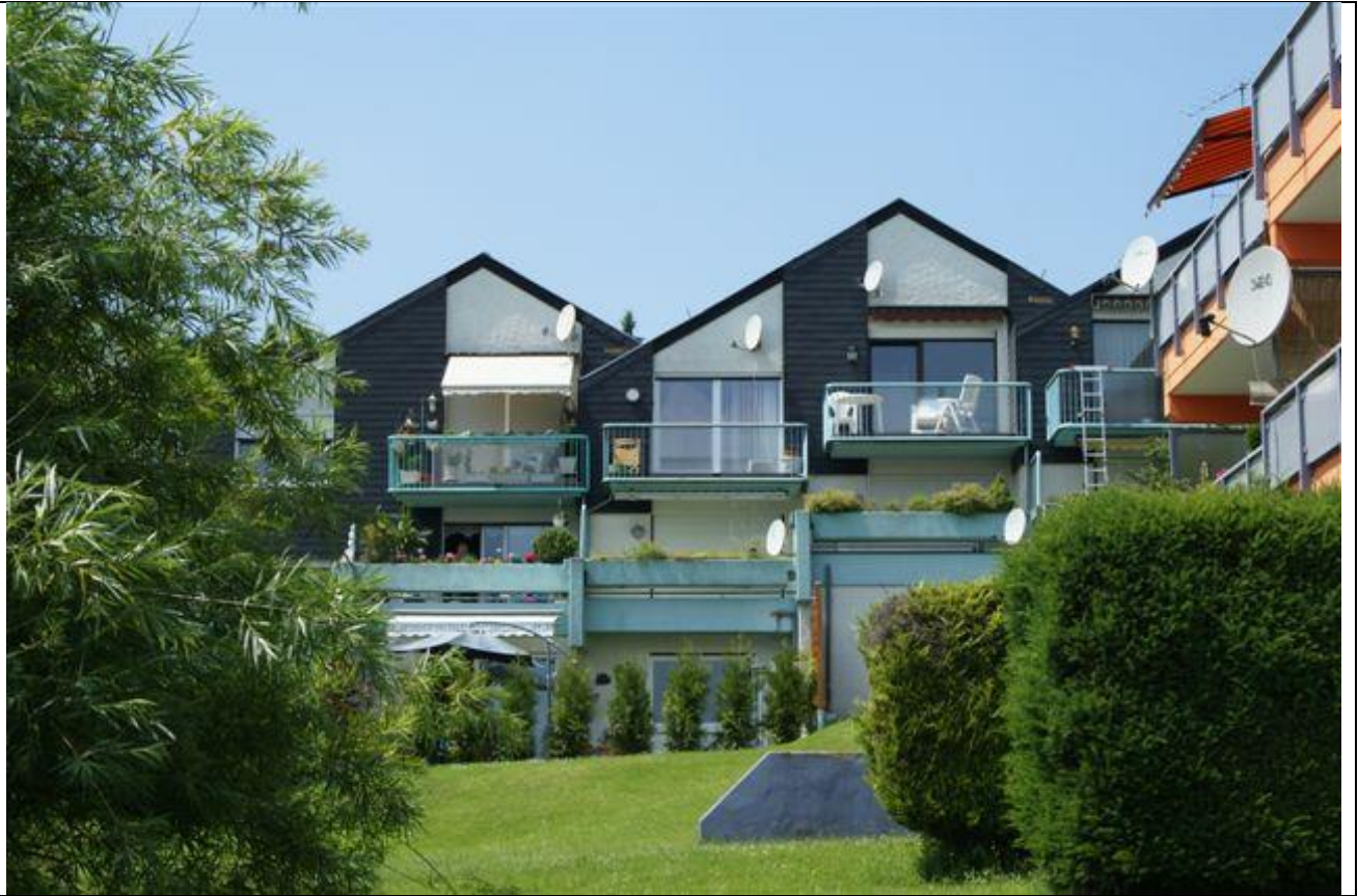
Ansicht der Wohnanlage
