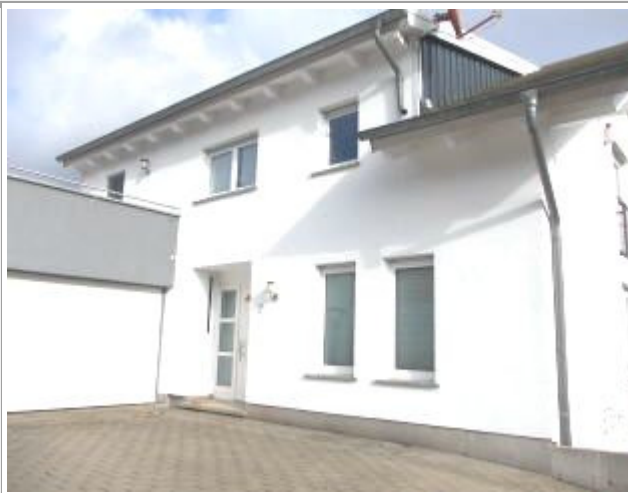
Eingang, links die Doppelgarage
